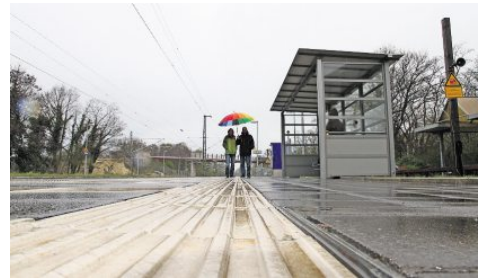
Bahnkunden stehen im Regen: Von Haltepunkt zu Haltepunkt geht es nur über die Brücke (im Hintergrund). Rollstuhlfahrer müssen über die Straße. Es führt nur eine Treppe direkt hinauf. Foto Schwerdtfeger
